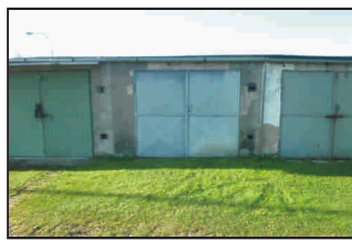
Garáž v Tachově, ul. Sokolovská
