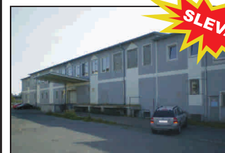
Komerční objekt v Tachově, ul. Plánská
