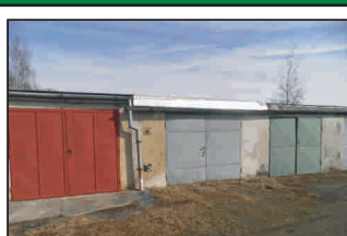
Garáž v Tachově, ul. Sokolovská
