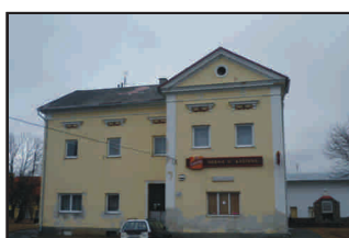
Dům s ubytovnou a restaurací v Chod. Plané
