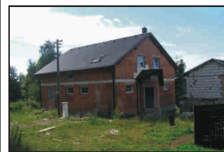
Rozestavěný rodinný dům v obci Horní Výšina
