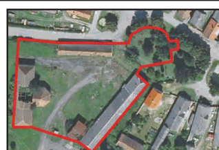
Zemědělské stavby v obci Nahý Újezdec
