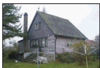
RD v obci Čechovice u Boru
